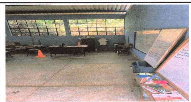
Foto # 6: Sustitución de piso ceramico
