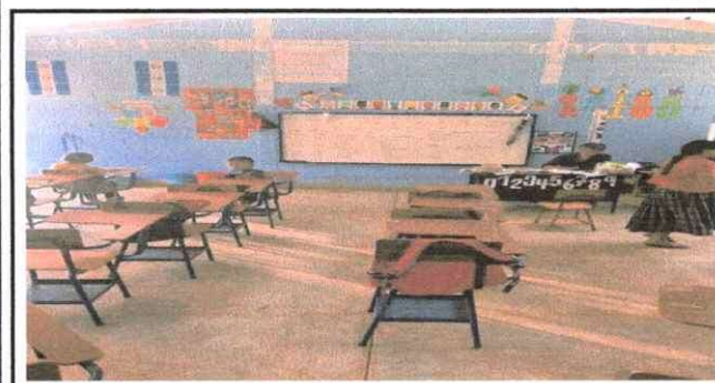
Foto # 5: Sustitución de piso ceramico
